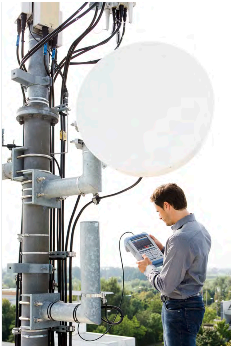
Анализатор R&S®FSH, используемый на этапе монтажа и обслуживания передающих станций
